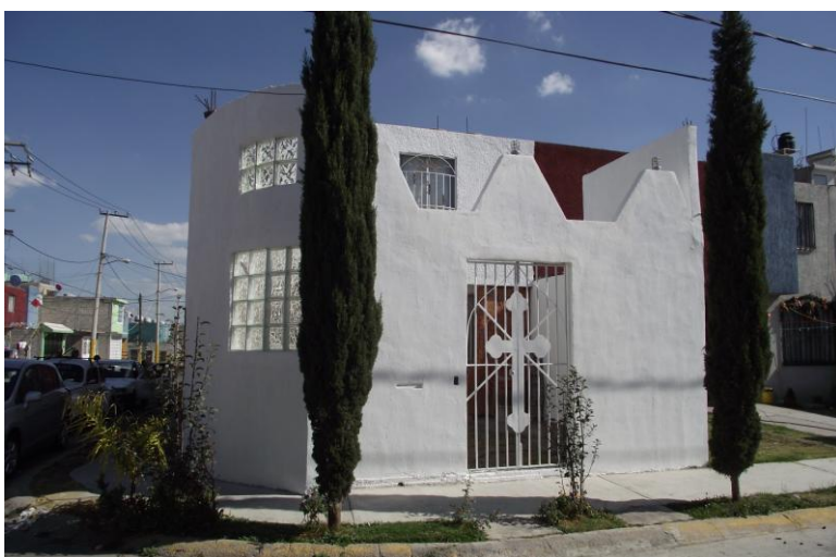
Esta es la sencilla residencia del CFRM como actualmente se aprecia.
